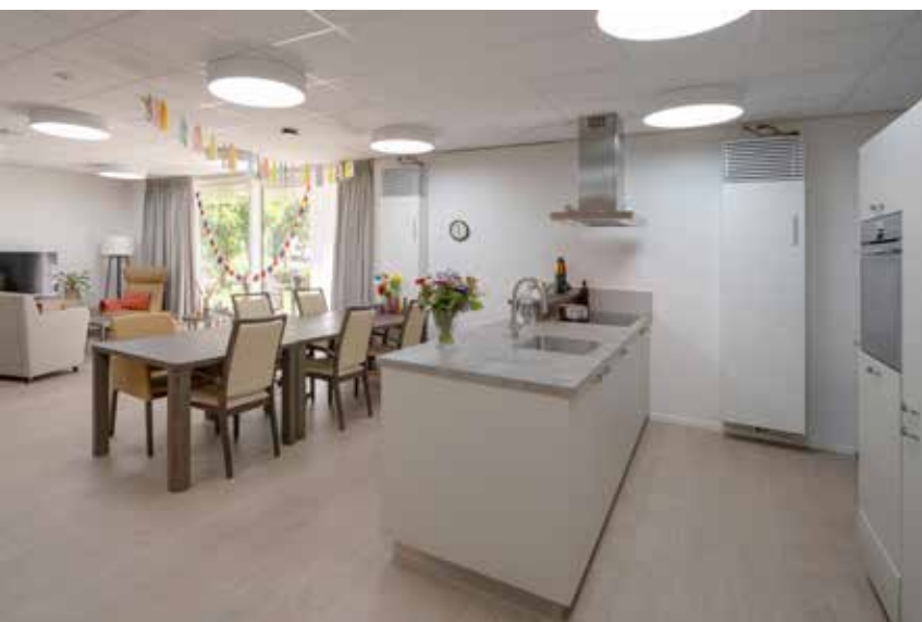
ClimaRad Ventura VIC units in de gemeenschappelijke ruimtes.
