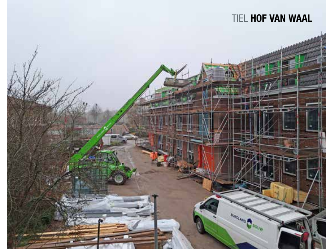
Hof van Waal in aanbouw. (Beeld: Burgland Bouw)
