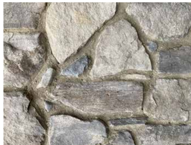
Het bouwproject wordt afgerond door het plaatsen van de Normandische plint, een verwijzing naar het moederhuis van de Zusters van Julie Postel. (Beeld: Sint Anna)
